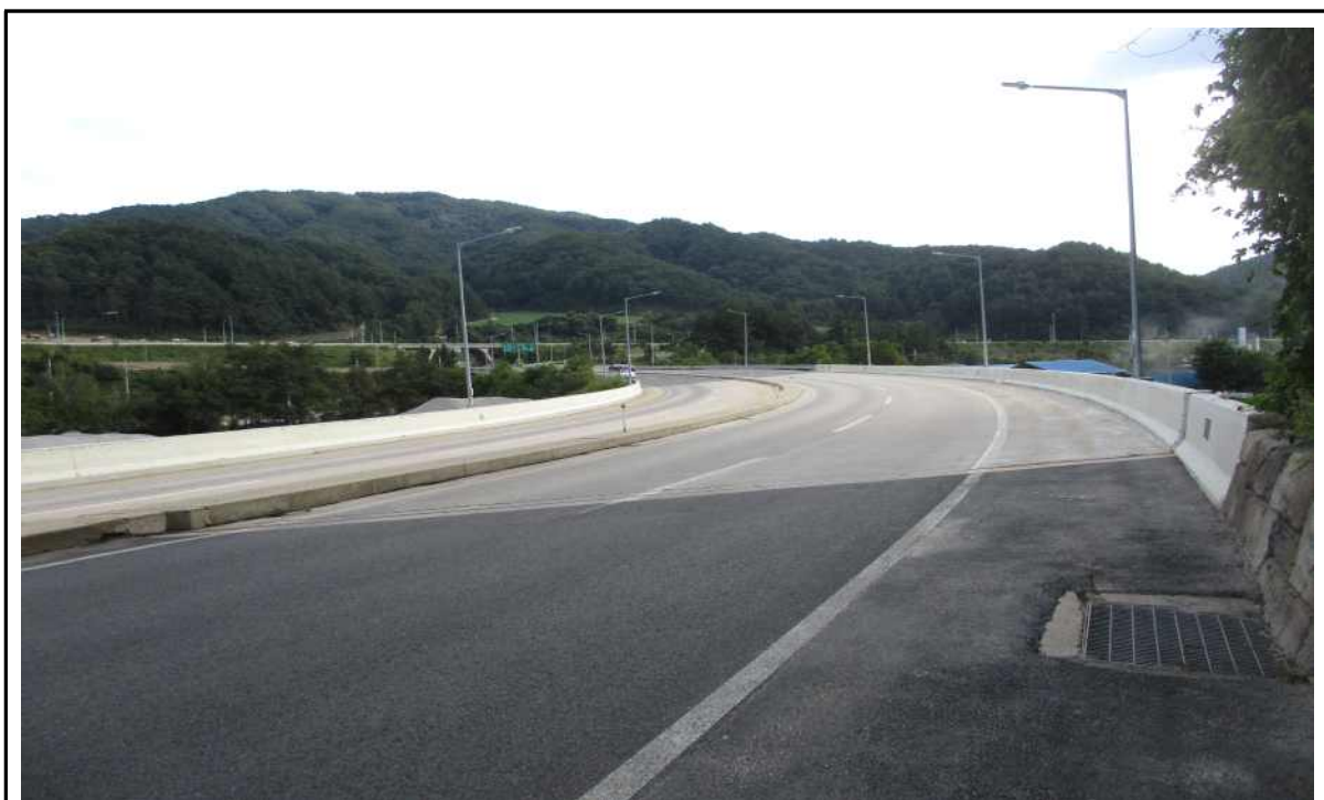
교량 상부 전경
